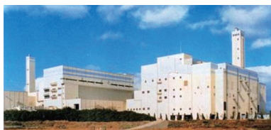
写真1 新S-TEN1の適用例（ごみ焼却施設）
